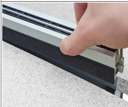
Rys. 11: Wsuwanie wylotu szczelinowego
