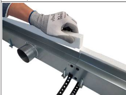
Rys. 9: Zdejmowanie montażowej osłony ochronnej.
