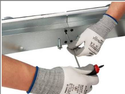
Rys. 7: Skręcanie skrzynek przyłączeniowych
