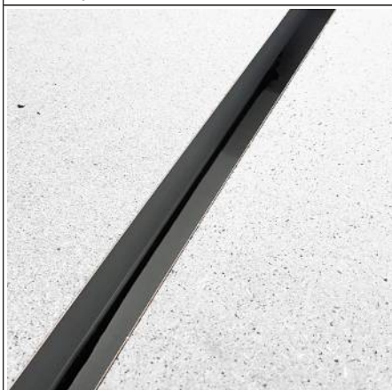
Rys. 10: Skrzynka przyłączeniowa zlicowana z podłogą
