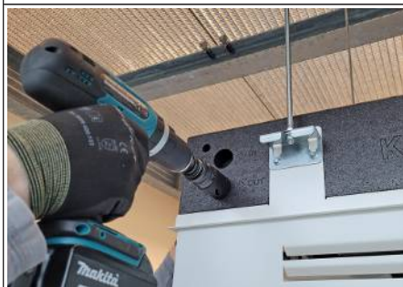
Rys. 16: Otwieranie otworów przyłączeniowych
