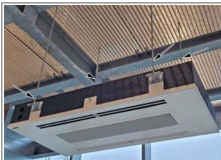
Rys. 6: Urządzenie niezawieszone
