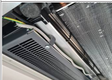
Rys. 19: Układanie kabla siłownika
