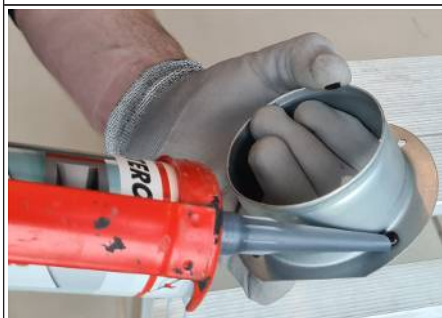
Rys. 24: Uszczelnianie króćca przyłączeniowego powietrza pierwotnego
