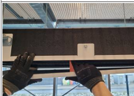
Rys. 8: Wciskanie blachy zabezpieczającej
