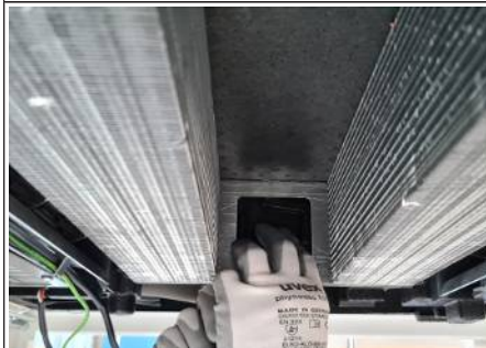
Rys. 25: Demontaż osłony powietrza pierwotnego
