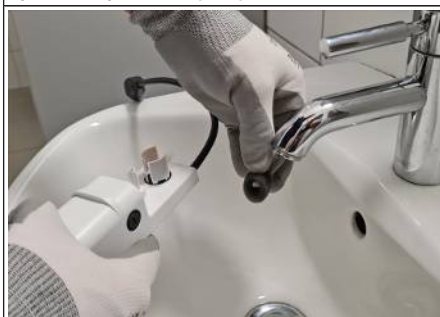
Rys. 46: Czyszczenie filtra zanieczyszczeń
