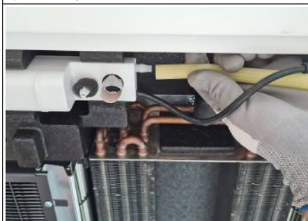
Rys. 21: Przymocowanie węża kondensatu do pompki kondensatu
