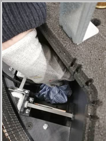
Rys. 34: Wyczyścić niszę pompową.
