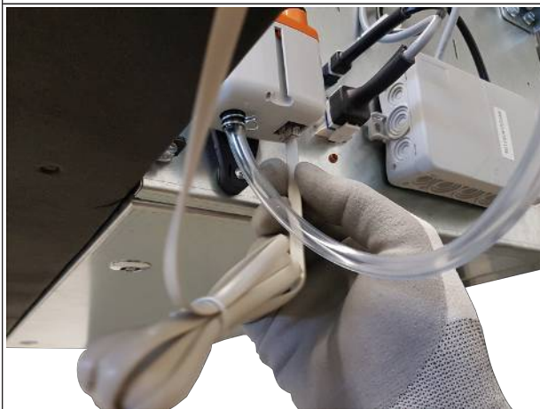
Rys. 29: Podłączanie kabla sygnałowego przełącznika pływakowego
