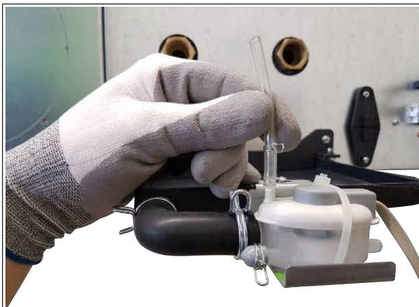
Rys. 24: Zakładanie odpowietrzenia
