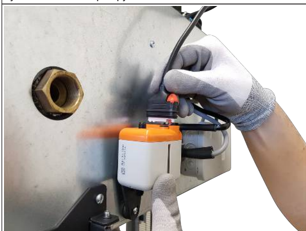
Rys. 26: Podłączanie zasilania
