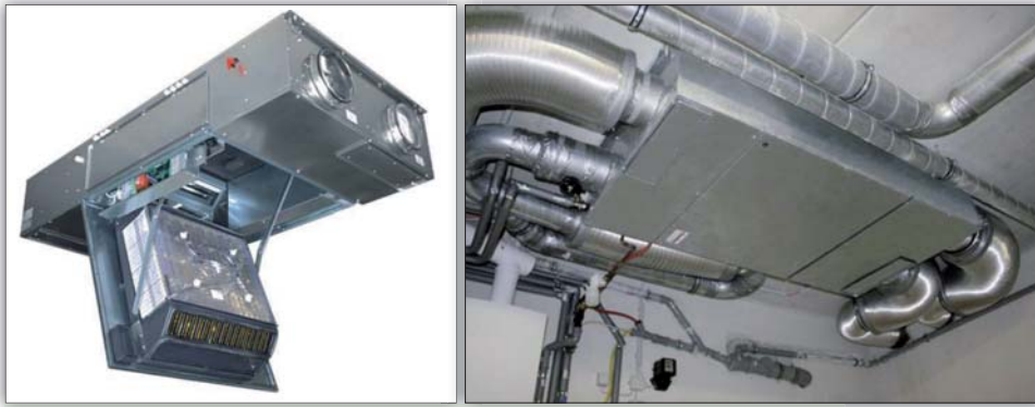
Fot. 1 Centrala wentylacyjna z rekuperacją, obejściem oraz chłodzeniem adiabaticznym
